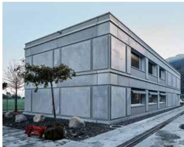
Tragwerk und Fassade des neuen Bürogebäudes der Fanger Elementtechnik AG sind aus Beton und wurden selbstverständlich selbst produziert und montiert.
